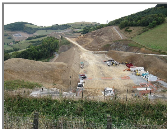
Autre vue du chantier de l'A89 vers Tarare
